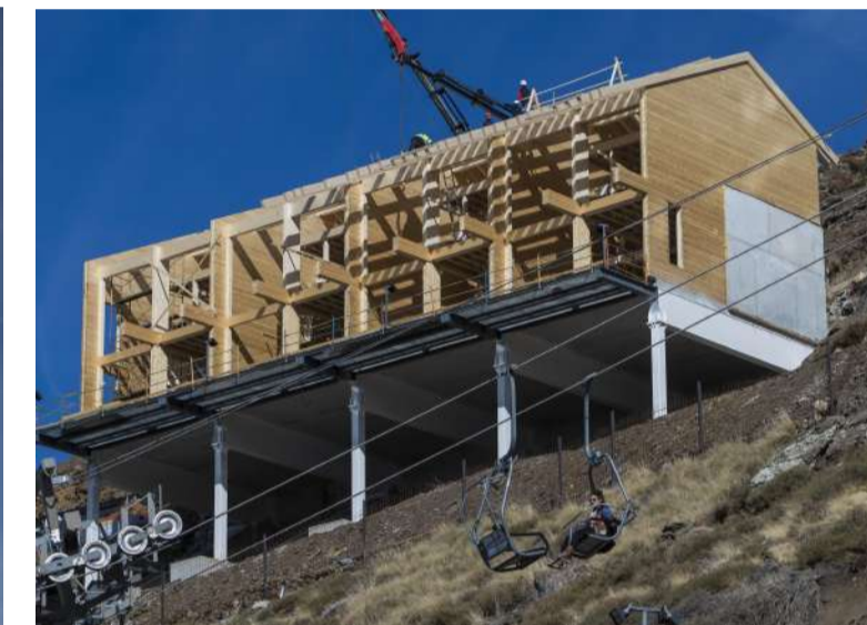
Las obras de la primera casa, junto al telesilla Parador. :: PEPE MARÍN
